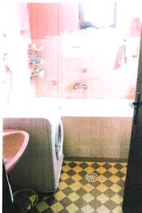
Fotografija broj 12: Prikaz kupatila u sastavu prizemne etaže kuće kućni broj 10
