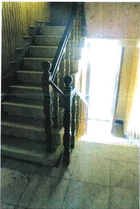
Fotografija broj 9: Prikaz unutrašnjeg stepeništa u kući kućni broj 10
