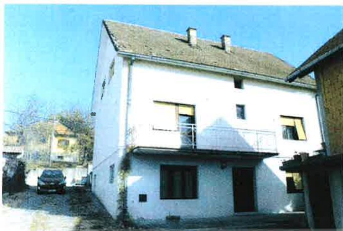
Fotografija broj 5: Prikaz dvorišne fasade kuće kućni broj 10, izgrađene na parceli broj 1257/1 K.O. Ostružnica
