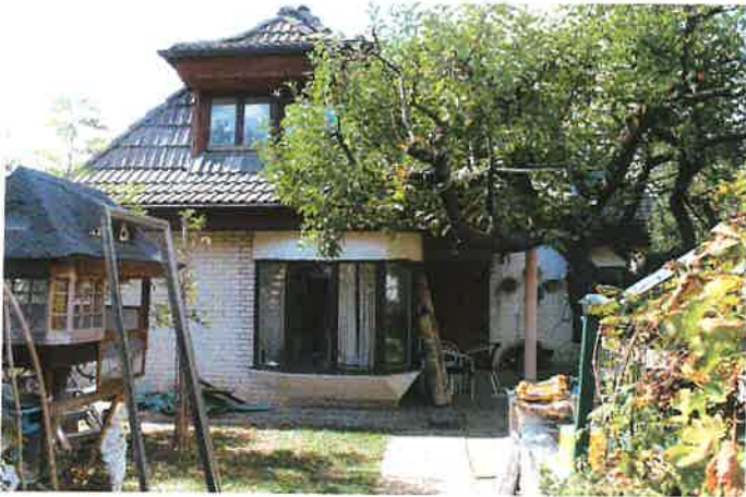
Fotografija broj 5: Prikaz porodične stambene zgrade, izgrađene u ulici Gorička 67 u Sremčici, na parceli broj 3513 K.O. Sremčica
